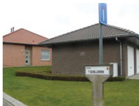
bouw woningen en garages 't Schellewerk
