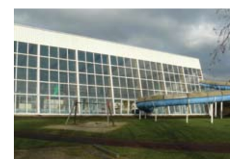
bouw van een nieuw zwembad
